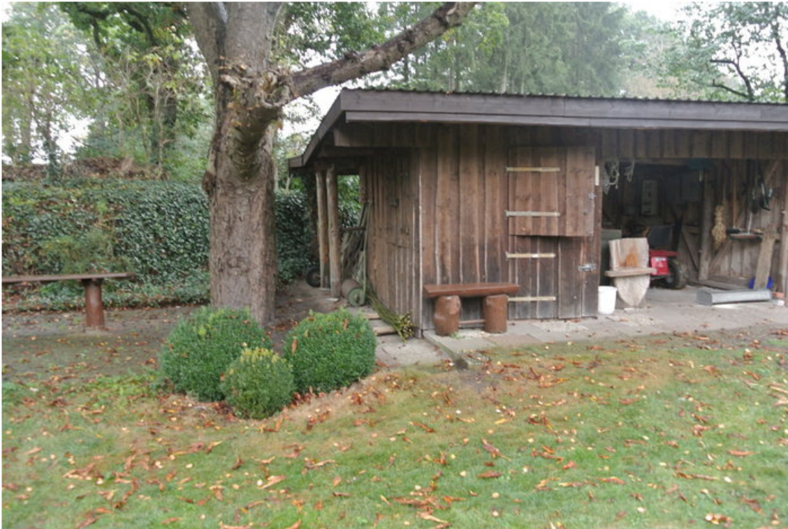
Lindenstr.7, Hardebek – Grundstück/Hinterland mit Geräteschuppen
